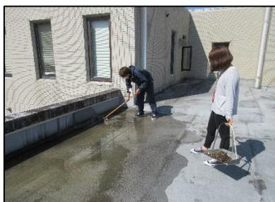
現地調査の際に発見した排水溝の詰まりを清掃している様子
