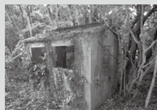
▲大浦監視哨(外観)
