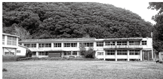
解体処分を待つ公共施設
