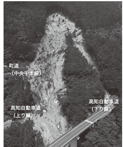
大豊町立川千本で発生した山腹崩壊 (平成30年7月撮影)
