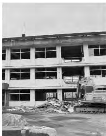
解体が進む旧大月分校
