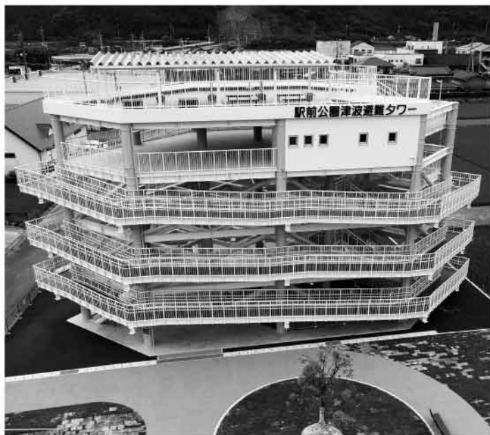
宿毛駅前公園津波避難タワー
