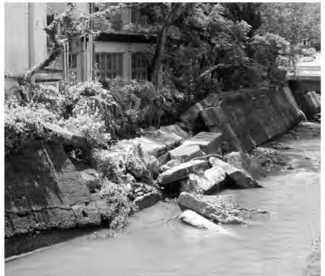
▲地盤が緩み、土砂崩れやブロックが崩落を起こす箇所も多数発生。
