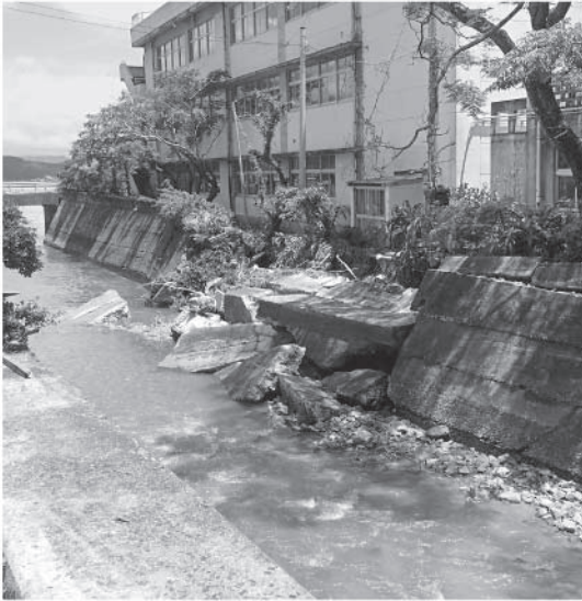
被災した橘浦川の復旧工事箇所
